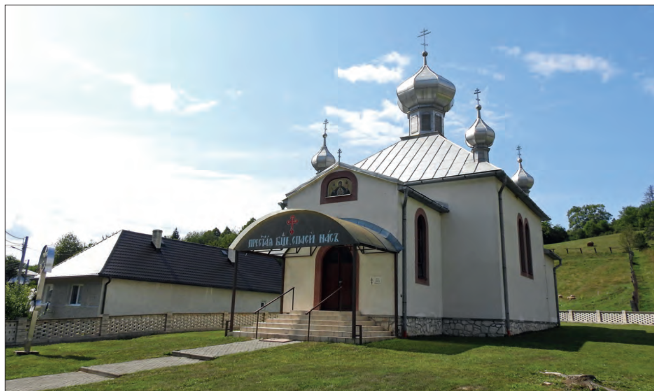
Pravoslávny chrám v obci Palota Cerkiew prawosławna w Palocie
