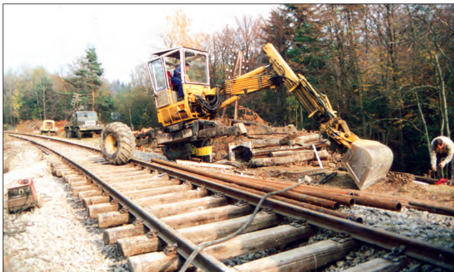
Spevňovanie železničnej trate pred jej opätovným uvedením do prevádzky v roku 1996
