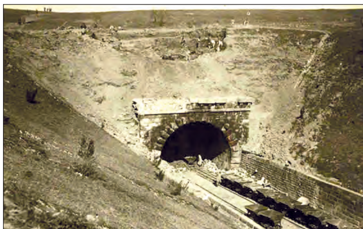
Oprava poškodeného Lupkovského tunela v roku 1915 Odbudowa uszkodzonego tunelu łupkowskiego w 1915 roku
