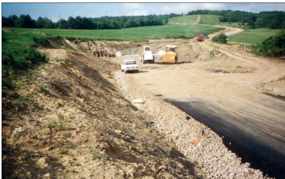
Výstavba novej cestnej komunikácie k slovensko-poľskej hranici v roku 2002 Budowa nowej drogi gminnej do granicy polsko-słowackiej w 2002 roku
