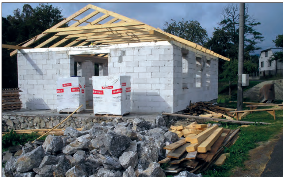
Výstavba Domu smútku Budowa domu pogrzebowego
