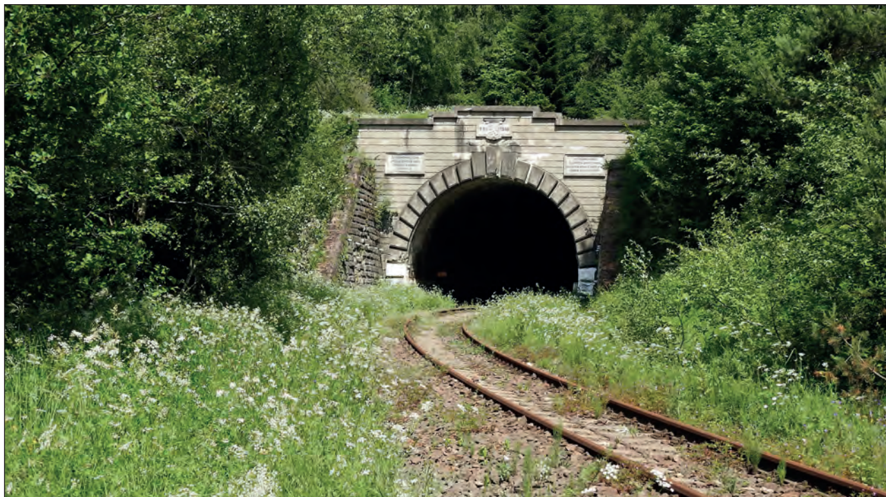
Lupkovský tunel Tunel kolejowy w Łupkowie
