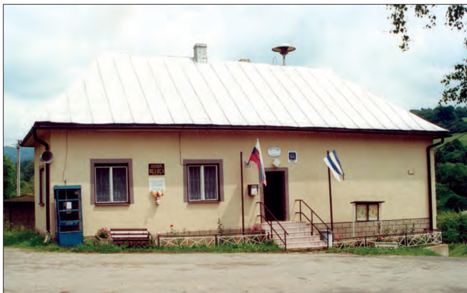
Budova obecného úradu pred rekonštrukciou Budynek Urzędu Gminy przed remontem
