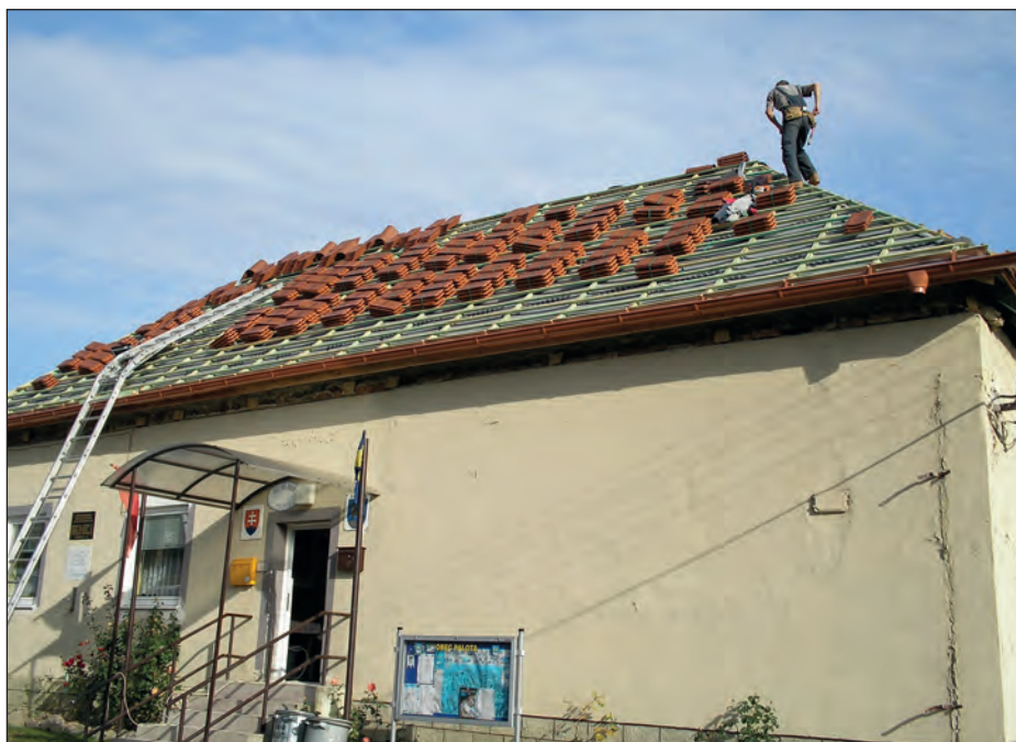
Rekonštrukcia budovy obecného úradu Remont budynku Urzędu Gminy
