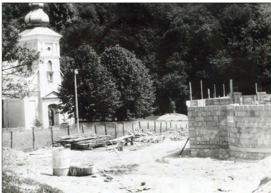
Gréckokatolícky chrám (vľavo) a rozostavaný pravoslávny chrám (vpravo) Cerkiew greckokatolicka (po lewej) i cerkiew prawosławna w trakcie budowy (po prawej)
