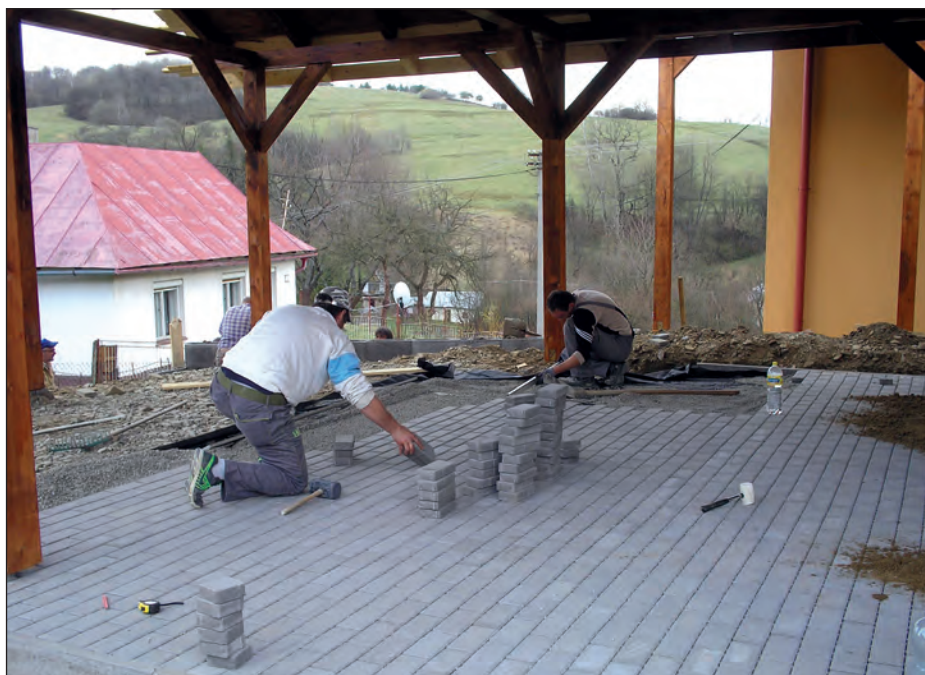
Budovanie multifunkčného areálu pri obecnom úrade Budowa obiektu wielofunkcyjnego koło Urzędu Gminy
