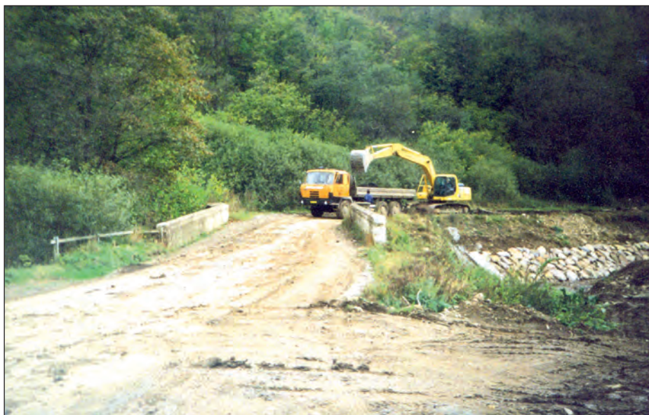
Búranie starého a stavba nového mosta cez rieku Vydraňka Burzenie starego i budowa nowego mostu nad rzeką Vydraňka
