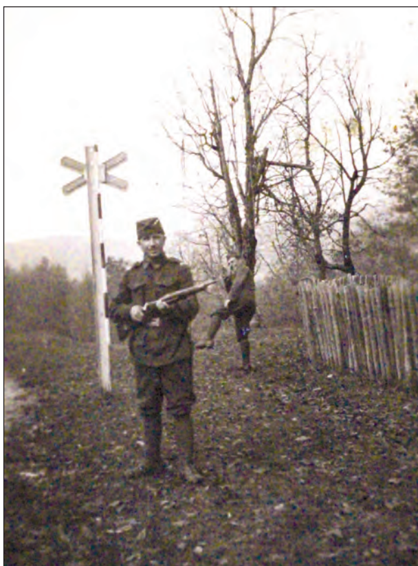
Andrej Medviď – veliteľ oddielu československej domobraný, ktorá v rokoch 1938 – 1939 strážila železničnú trať a Lupkovský tunel Andrej Medviď – dowódca oddziału pomocniczego armii czechosłowackiej, który w latach 1938 – 1939 patrolował linię kolejową i tunel łupkowski
